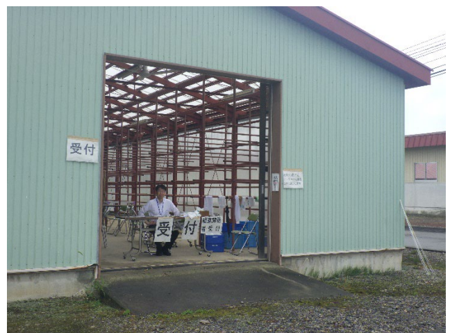
テントの雨漏りのため受付場所を移動しました
