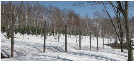
積雪によるネットの破損を軽減する設置方法を開発しました。
