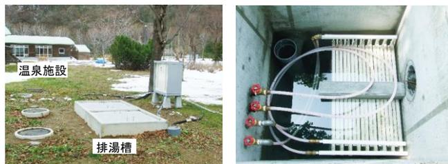
排湯槽と槽内の熱交換器の外観
