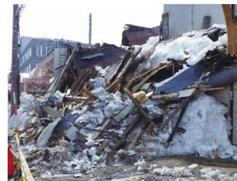
積雪期の降雨による影響で倒壊した建物（北海道内）
