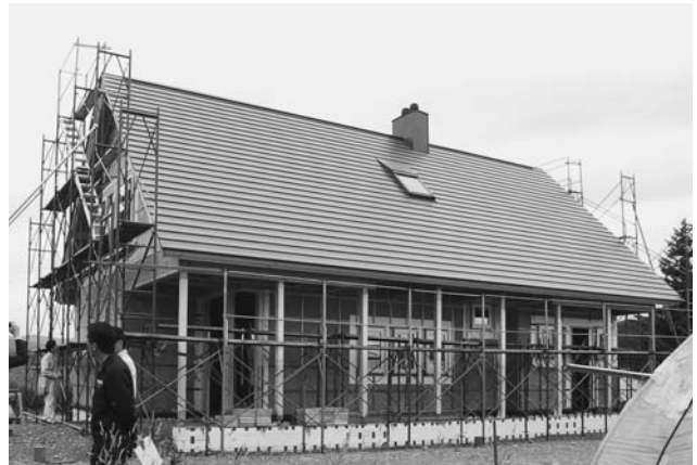
(2) 施工中の外観
