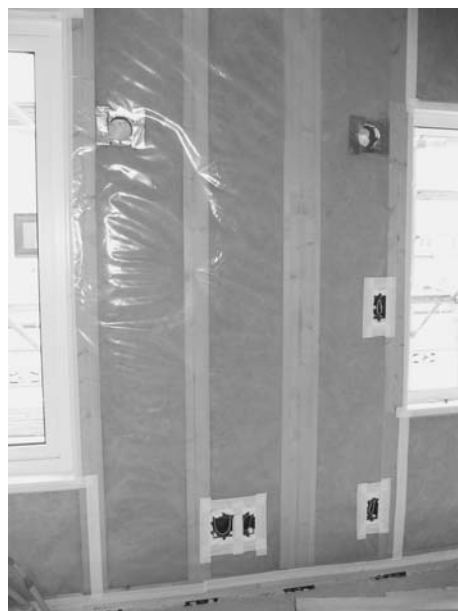
写真5 設備配管、コンセント廻りの気密化例
