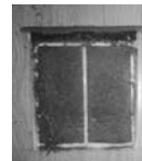
熱交換換気装置内 給気側フィルター
