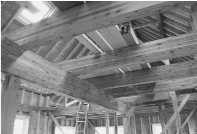
(1) 施工中の室内
