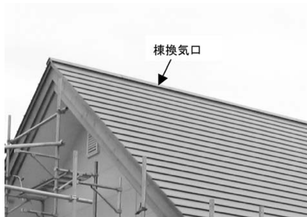
写真3 棟換気併用軒天換気方式の例
