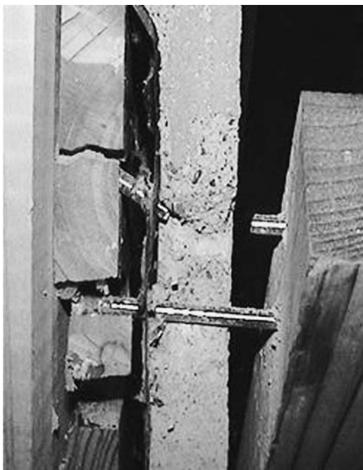
写真1 施工性の向上を図る、あるいは新しい壁工法を開発する際にはビスの性能も確認
