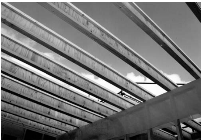
写真2 道産Ⅰ形梁による根太施工（枠組壁工法）
