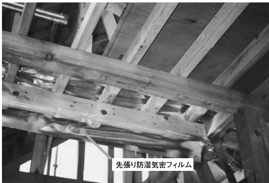
写真4 下屋部分に施工された先張り防湿気密フィルム
