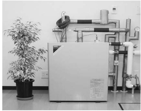
写真1 地熱ヒートポンプの例
