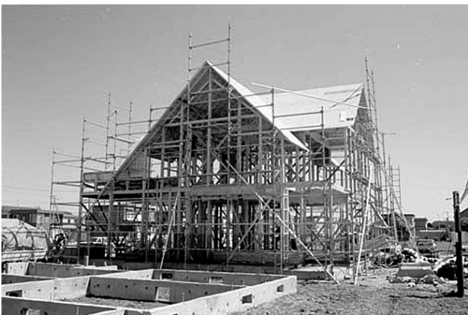
写真1 木造住宅の建設（在来軸組構法）
