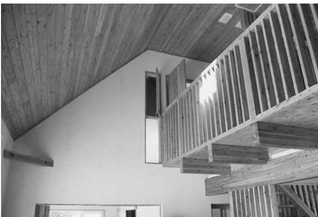
(3) 完成時の室内
