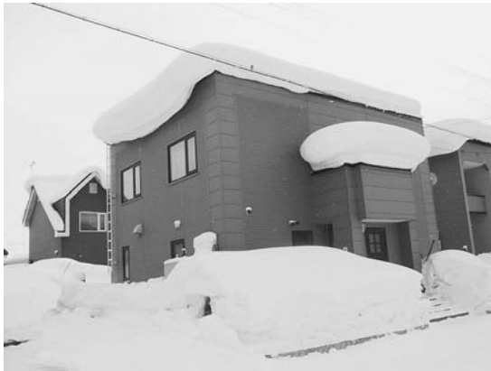
写真1 住宅の雪庇(滝川市)
