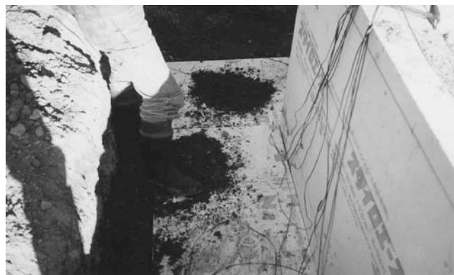
写真2 スカート断熱の施工例
