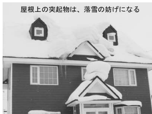
写真1 複雑な屋根計上での落雪障害
