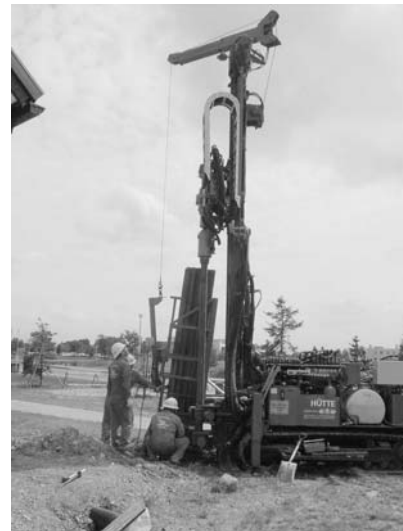
写真2 地中熱交換器の設置工事
