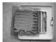
室内排気口フィルター
