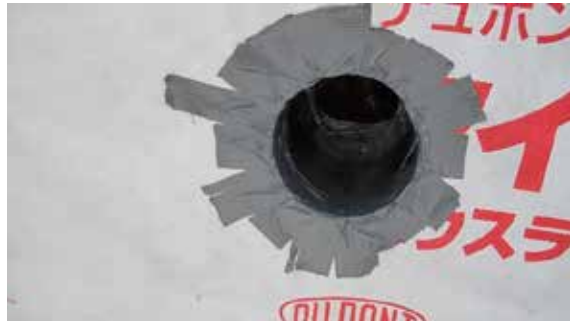
写真26 透湿防水シート 配管周り
