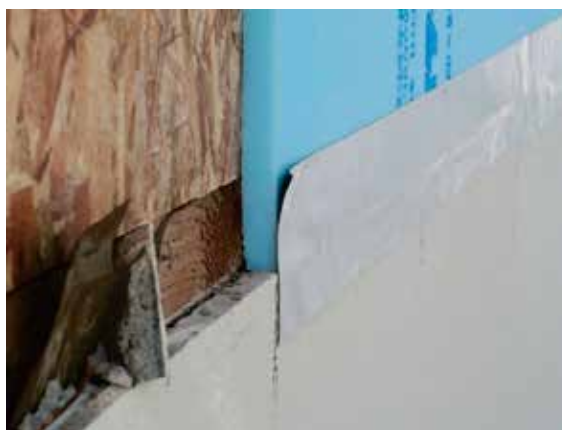
写真13 XPS板の防水
