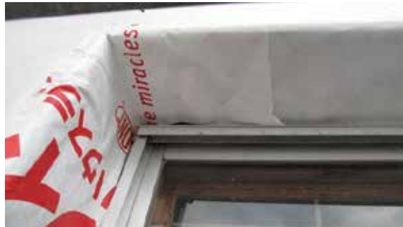
写真25 透湿防水シート 窓周り
