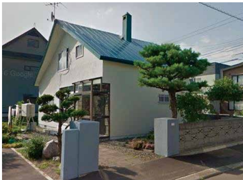
改修前の外観
