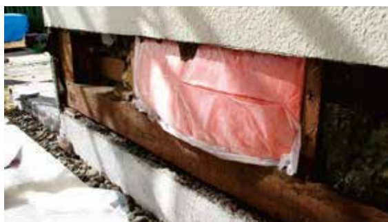
写真9 気流止め材切り込み
