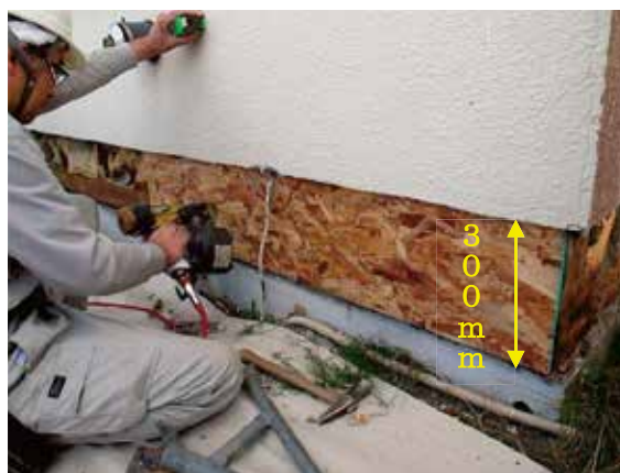
写真10 OSB合板張り土台周り
