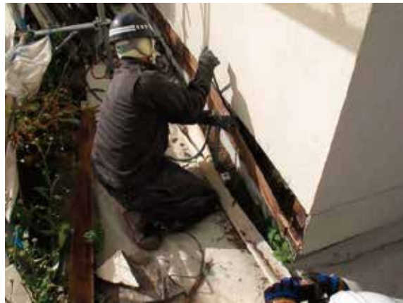
写真6 下地板撤去
