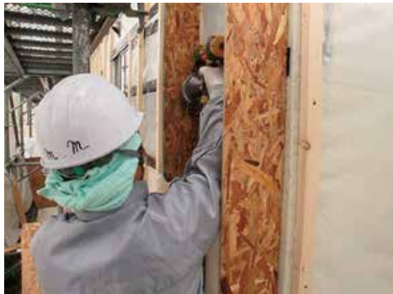
写真17 ふかし下地の固定
