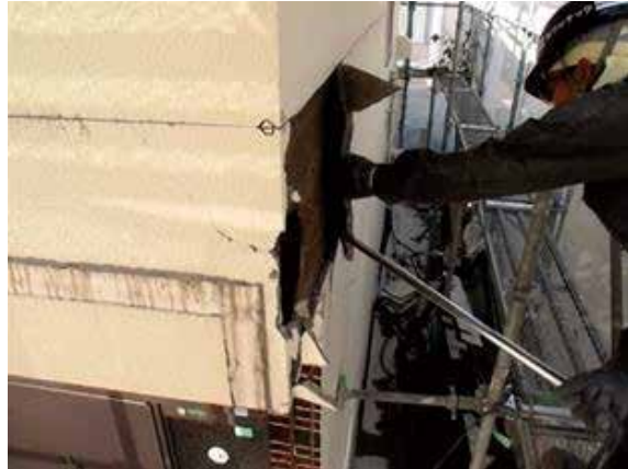
写真5 モルタル撤去桁周り
