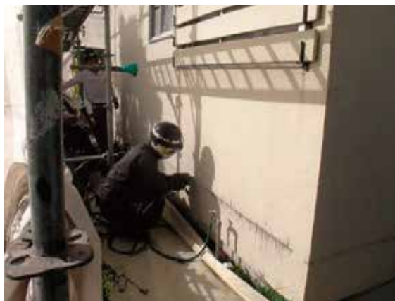
写真2 モルタルカット土台周り
