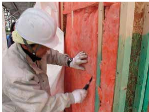
写真 2 3 断熱材の切込み
