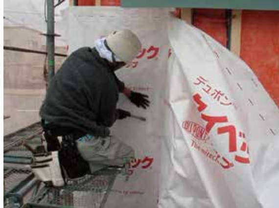
写真24 透湿防水シート張り
