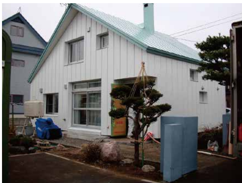
改修後の外観
