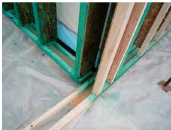
写真20 壁ふかし出隅の施工
