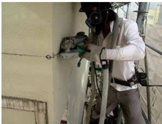
写真3 モルタルカット桁周り
