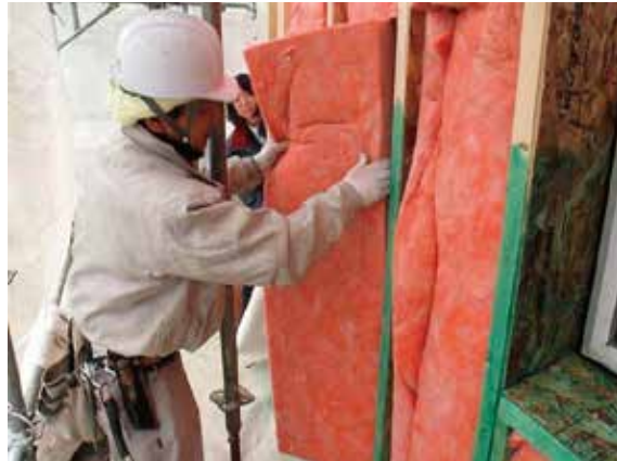
写真 2 1 グラスウール挿入
