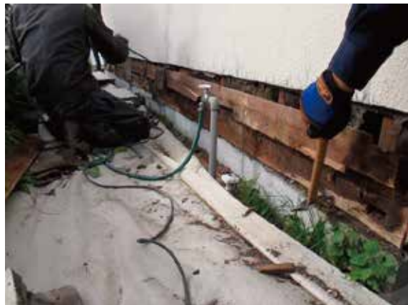
写真7 躯体の打診検査
