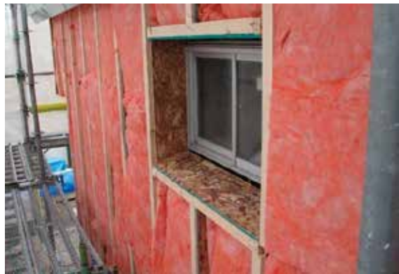
写真 2 2 窓周りの断熱施工
