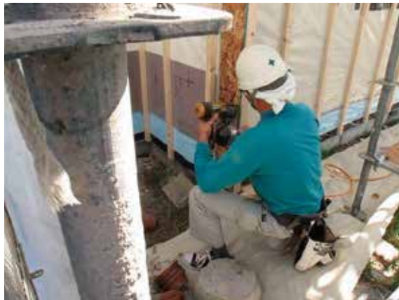
写真16 外側垂木留め付け
