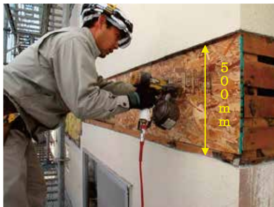
写真11 OSB合板張 桁周り
