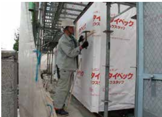
写真27 通気胴縁釘打ち
