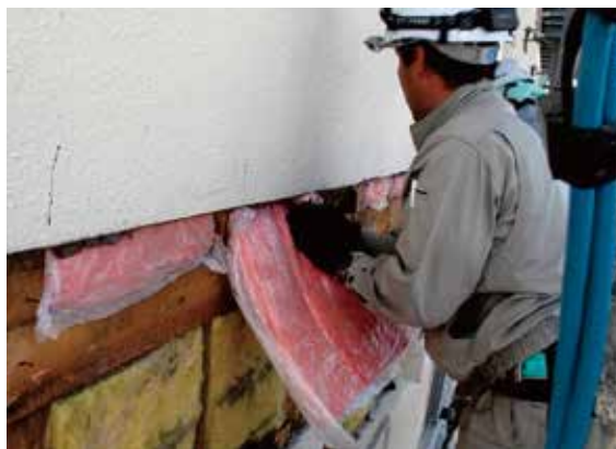
写真8 気流止め材挿入
