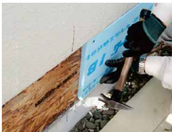
写真12 XPS板による不陸調整
