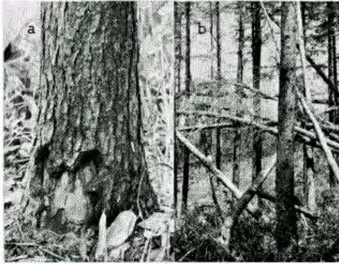
写真-3 野ネズミ被害状況
