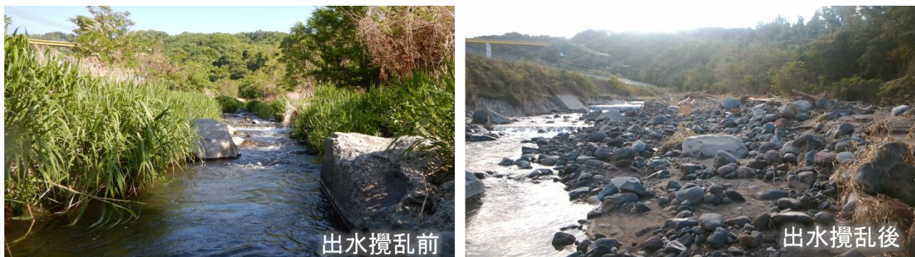
図-1 令和元年東日本台風前後の調査河川（群馬県・沼尾川）の様子 写真左上の橋が両写真の比較に有効な目印。Ishiyama et al. (2023b) より抜粋。
