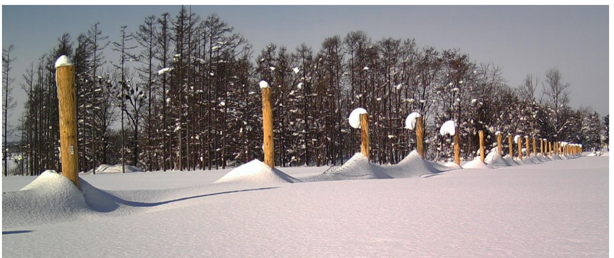
写真-3 ステーブルの脱落によりネットが落下した侵入防止柵（2016年2月8日）
