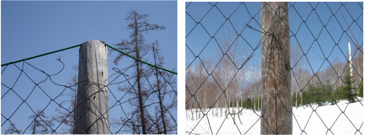
写真-4 木口面で固定したロープ(左)とネット固定部分(右)で発生したネットの破網
