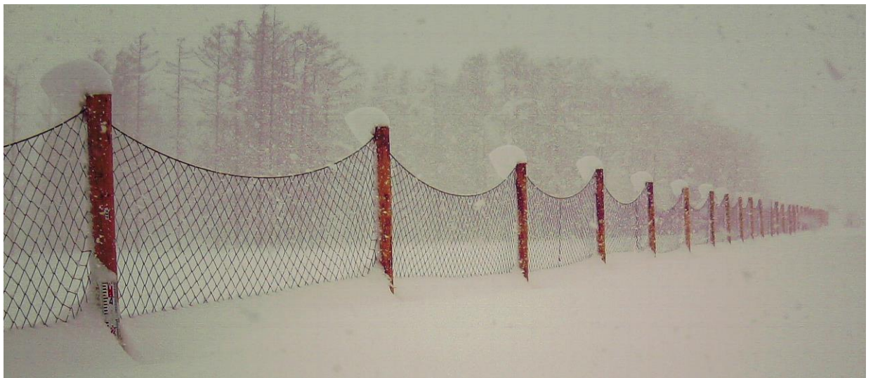
写真-2 積雪によりロープがたわんだ状態の侵入防止柵（2016年1月9日）
