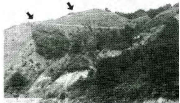
写真-2 尻岸内町古武井ジフィーポット苗植栽試験区前景(矢印はコンクリート土留工)
