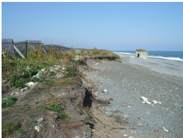
写真3 破壊された防風柵と砂浜上のトーチカ 侵食による浜崖が観られる(2007年10月4日)。
