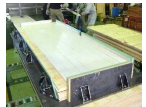
写真3 CLTパネル製造試験
