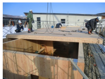
屋根パネルの施工
