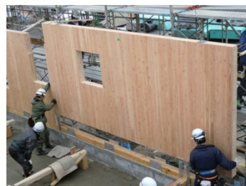
防腐処理土台と1階壁パネルの施工
