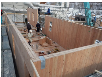
2階壁パネルの施工
