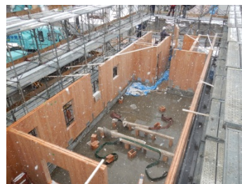
1階壁パネルの施工
