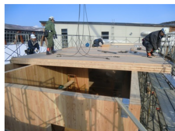
屋根パネルの施工
