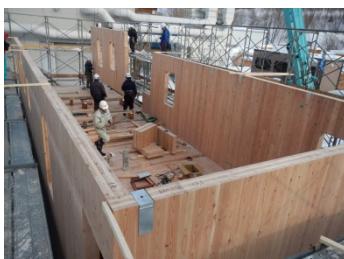
2階壁パネルの施工
