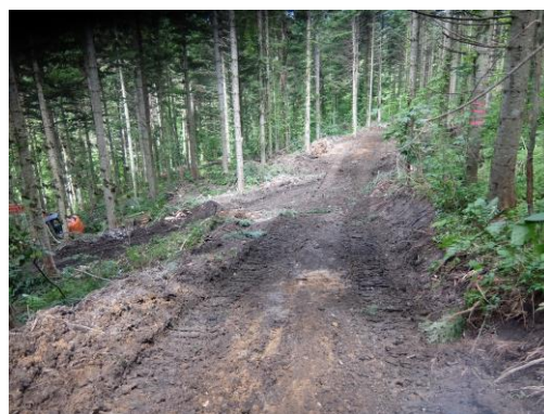
写真-4 修繕した道の様子
