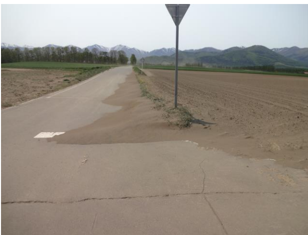
写真-3 道路に吹き溜まった畑の土
