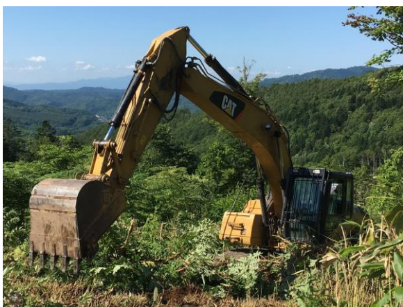
写真-4 残材除去作業に使用した機械 (写真は通常地拵え作業中のもの)
