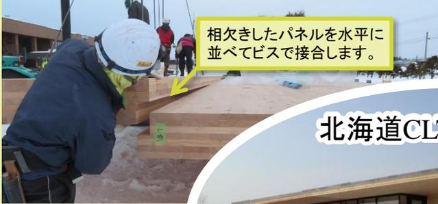
相欠きしたパネルを水平に並べてビスで接合します。
