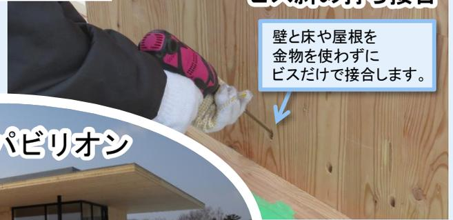
壁と床や屋根を金物を使わずにビスだけで接合します。
