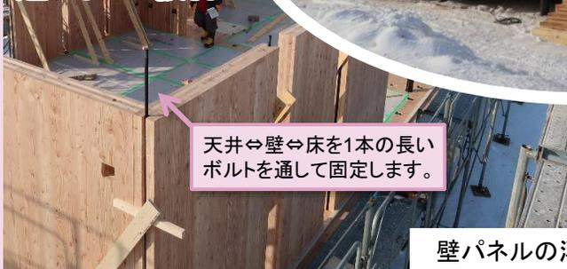
天井⇄壁⇄床を1本の長いボルトを通して固定します。
