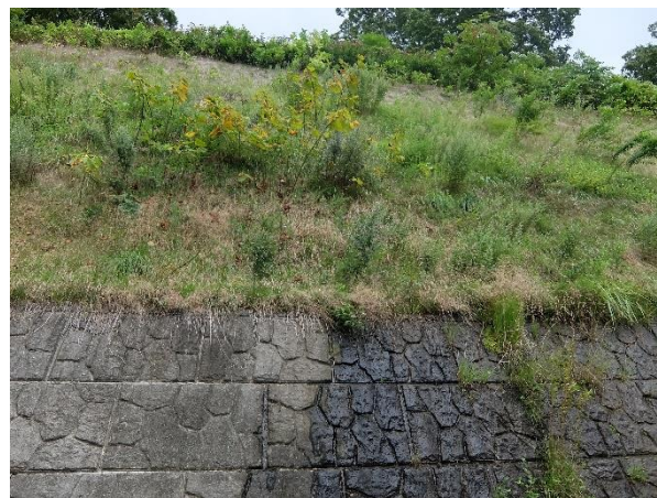
写真-10 広域基幹林道の切土のり面脚部の擁壁
