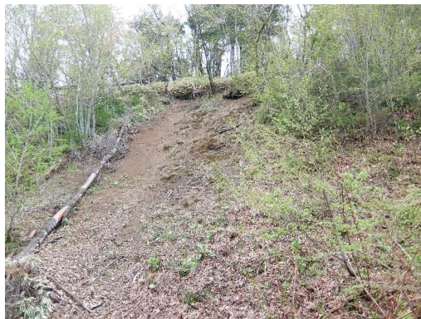
写真-1 表層崩壊タイプ
