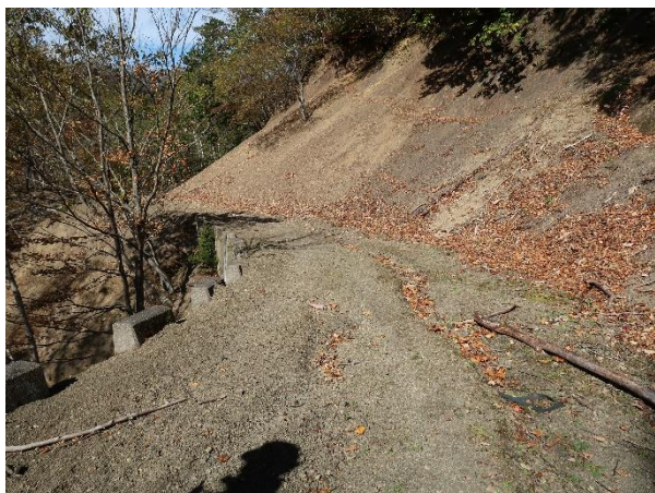
写真-11 盛土のり面に設置された擁壁
