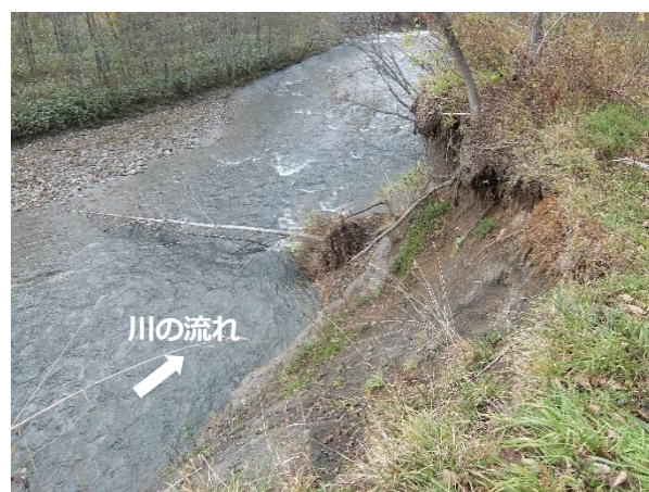
写真-7 溪岸侵食（崩落）
