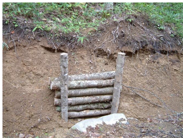
写真-19 呑口保護の簡易な方法
