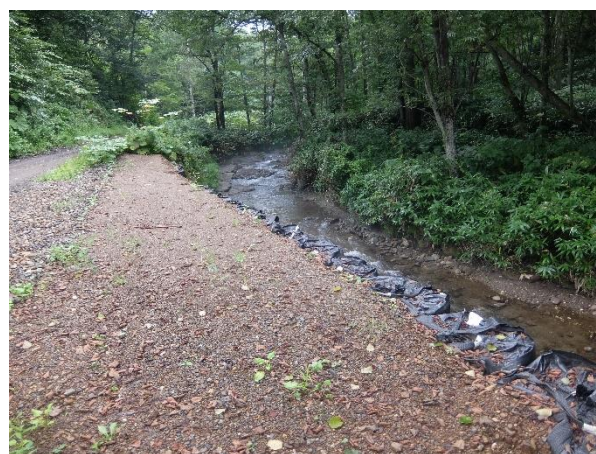
写真-14 大型土嚢による盛土のり面保護
