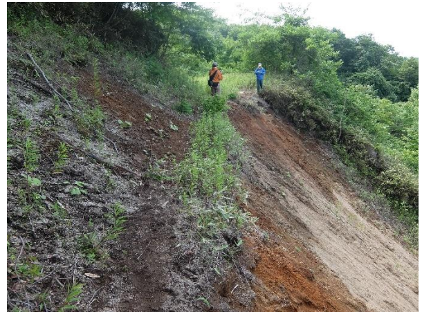
写真-1 表層崩壊タイプ
