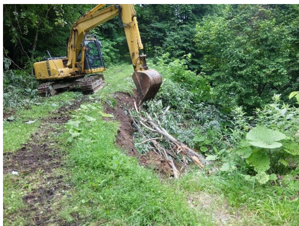
写真-15 盛土のり面崩壊の復旧
