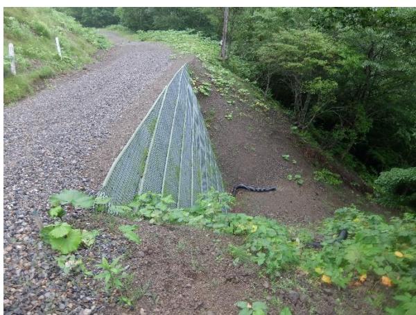
写真-13 盛土のり面保護工
