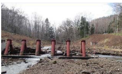
自然河川の蛇行の仕組みを活用した上下流分離型の流木補足工（治山工事）
