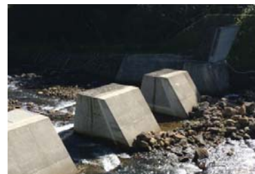
狭窄部の土砂補足機能と同様の効果のあるスリットダム（砂防工事）
