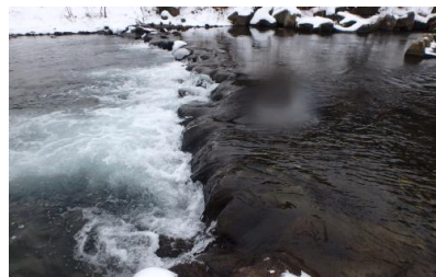
自然河川で石が安定して組み合う仕組みを工法に取り入れた石組帯工（河川工事）
