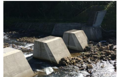
狭窄部の土砂補足機能と同様の効果のあるスリットダム（砂防工事）
