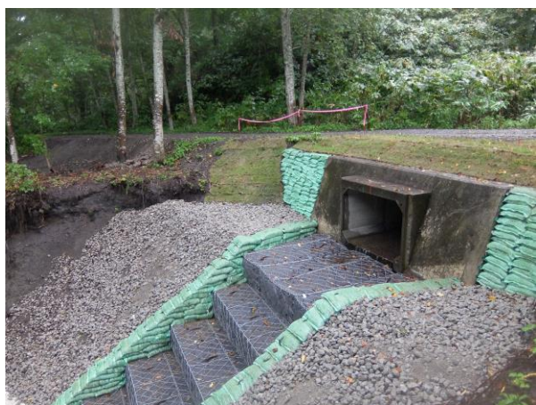
写真-12 ボックスカルバート
