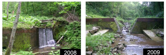
図-1 オマン川における治山ダムの改良事例
