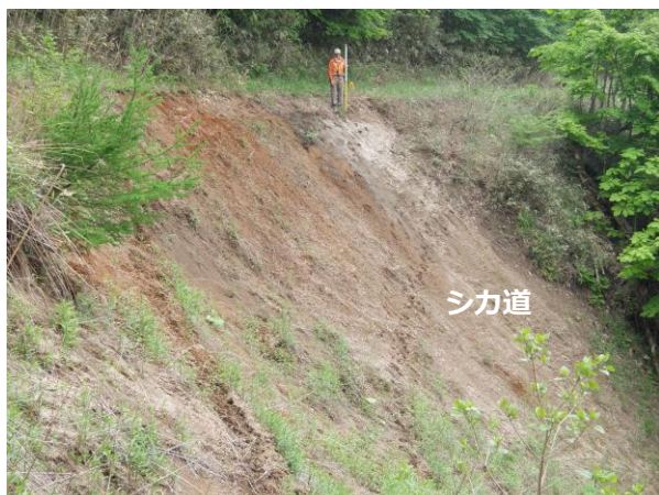
写真-2 地山ごと崩壊した道
