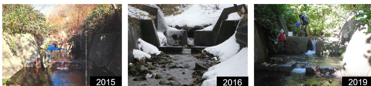
図-6 塩越川における治山ダムの改良事例
