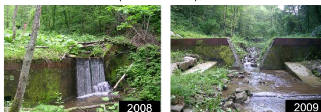
図-1 オマン川における治山ダムの改良事例
