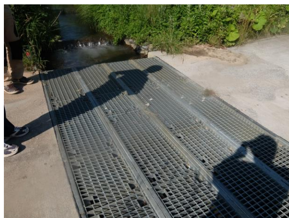
写真-16 グレーチング付き洗い越し
