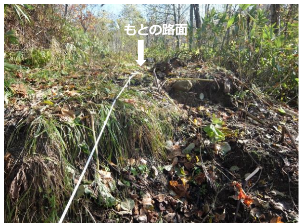
写真-7 沈み込んだ道にできた段差
