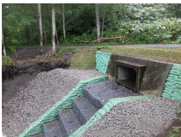
写真-12 ボックスカルバート
