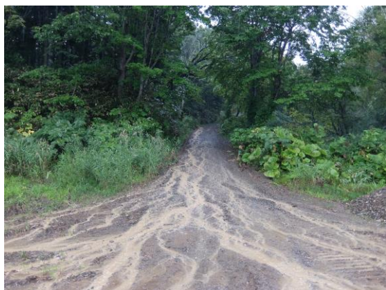
写真-8 降雨時に生じた濁水
