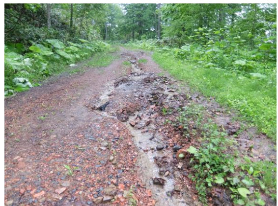
写真-7 ガリ内を流れる濁水
