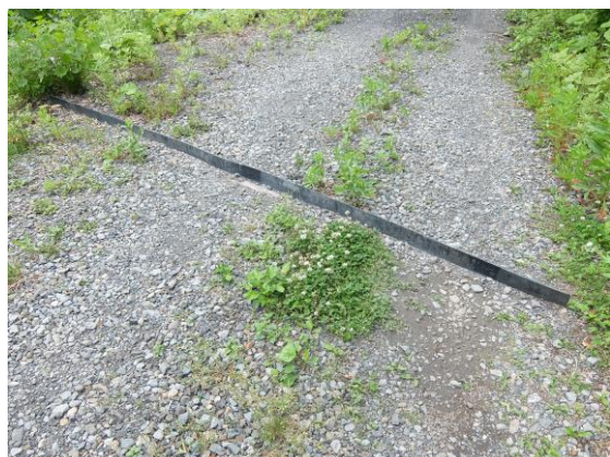
写真-17 ゴム製の止水施設
