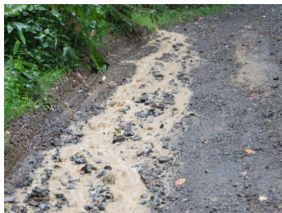
写真-9 側溝から流れる出る濁水
