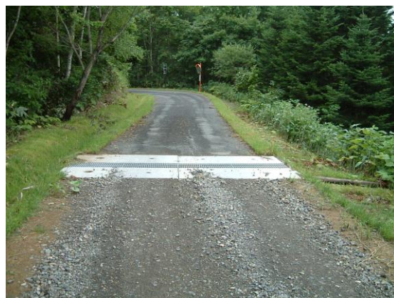
写真-18 コンクリート製横断排水溝
