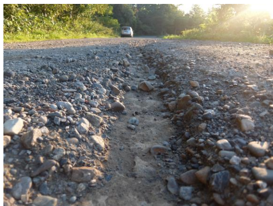
写真-12 砂利層だけが移動
