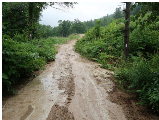
写真-6 路面を流れる濁水
