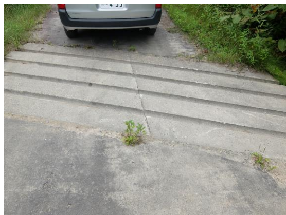
写真-16 路面排水版（板、盤ではないです）
