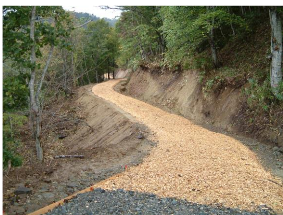
写真-21 木質チップを敷設した道路
