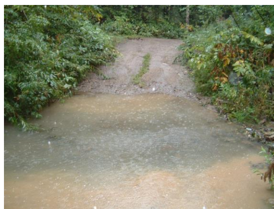
写真-2 手前と奥の路面から流れ込む濁水
