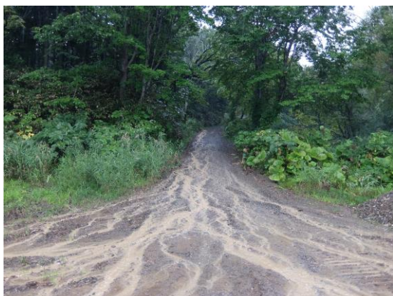
写真-8 降雨時に生じた濁水
