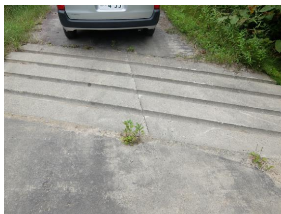
写真-16 路面排水版（板、盤ではないです）
