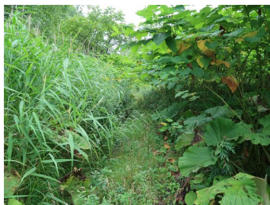
写真-22 植生が繁茂した道路
