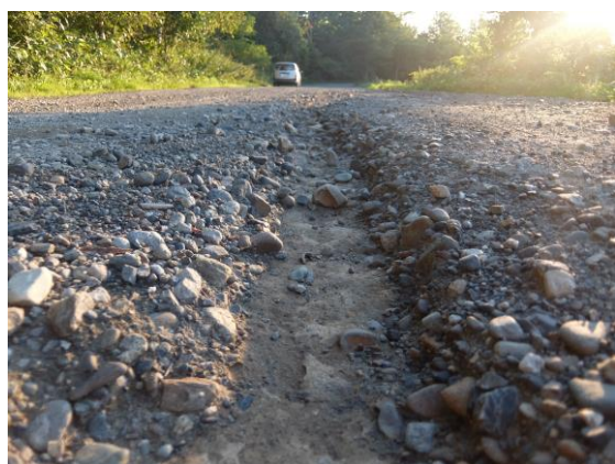
写真-12 砂利層だけが移動
