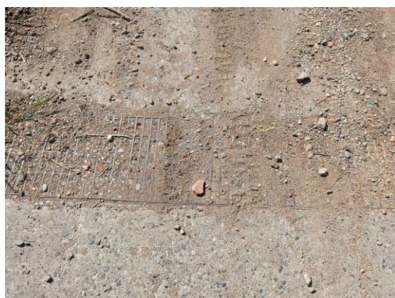
写真-19 埋没した横断排水明渠
