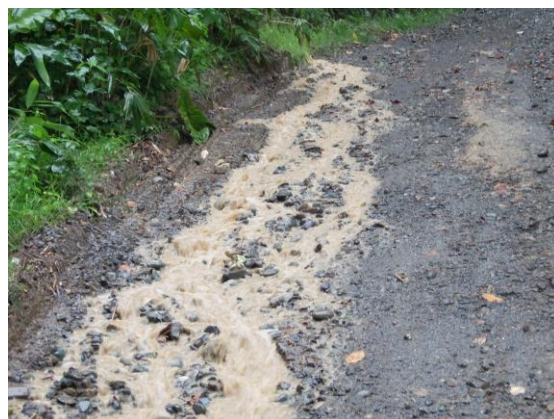
写真-9 側溝から流れる出る濁水
