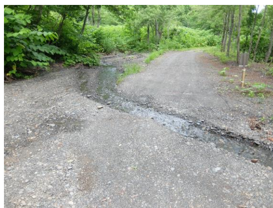
写真-5 川水による路面の削れ
