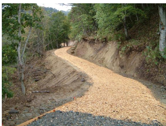
写真-21 木質チップを敷設した道路
