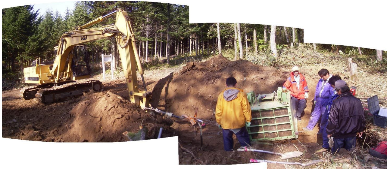
写真-1 根系を含む土の原位置せん断試験（光珠内実験林）
