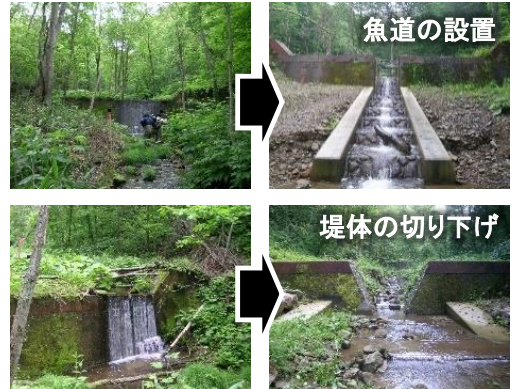
図1 治山ダム改良の様子。
