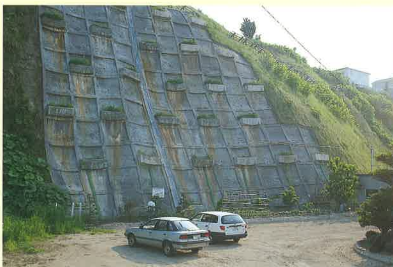
コンクリートで覆われた急斜面
