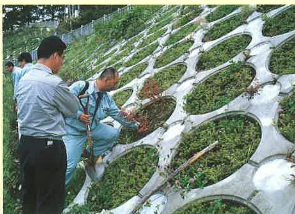
現地担当者との協議状況
