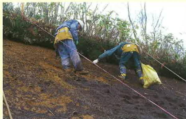
道路法面への木本導入試験
