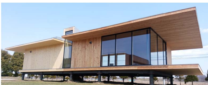
写真1 Hokkaido CLT Pavilion (CLT実験棟)
