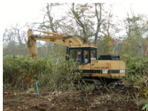
ビデオによる作業状況記録
