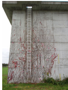
写真-1 植栽後4年が経過したツタ（東面）
