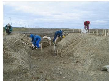
写真-1 荒廃海浜に人為的に作った盛土
