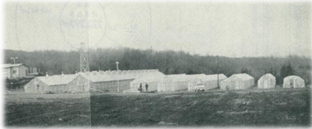
鹿部町内で実施されていた農業ハウス促成栽培施設（1967～）
