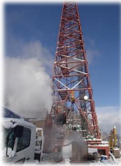
高温熱水の存在を確認 (H26.1) 深度800m付近で最高温度172℃
