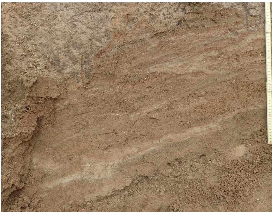
崩壊斜面近傍に見られた露頭
