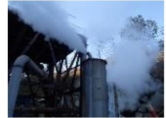
地熱井・熱水造成設備 (約90℃・1200～1300L/min)
