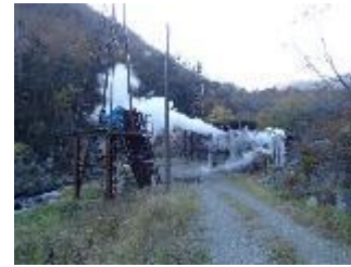
地熱井・熱水造成設備 (約90℃・1200～1300L/min)
