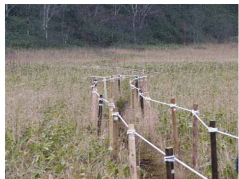
写真3 気相アセチル化スギ材を用いた植生保護柵
