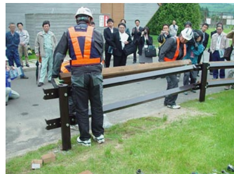
写真8 ビーム集成材の取り付け
