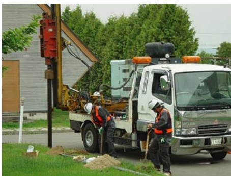
写真5 支柱の打ち込みと根巻き用の穴掘り
