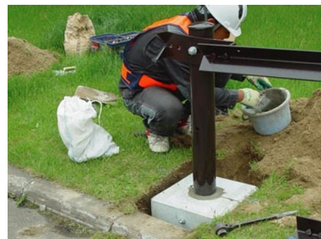
写真7 支柱と根巻きコンクリートの固定
