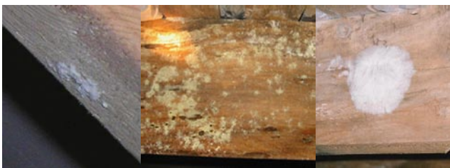
図1 住宅部材に発生した菌類（目視での判別は難しい）
