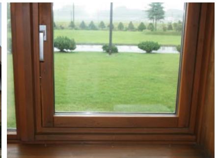
室内側（林産試験場庁舎）
