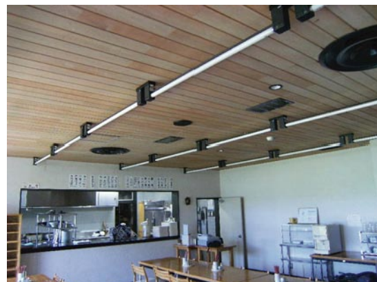
天井が難燃処理アサダ材 の林産試験場食堂
