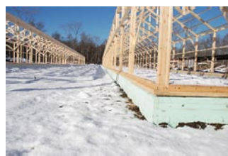
写真3 木造無加温温室の基礎
