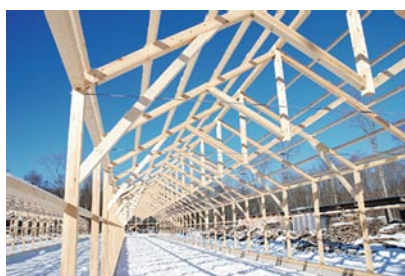
写真4 木造無加温温室の構造
