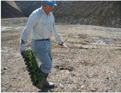
写真-3 施工地でのササ苗の扱い
