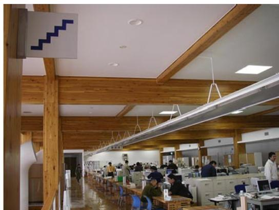
写真1 構造用集成材を使用した大規模建築物（足寄町役場庁舎）
