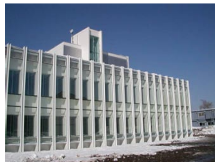
写真 15 大判の Low-E ガラスを用いたダブルスキンのカーテンウォール
