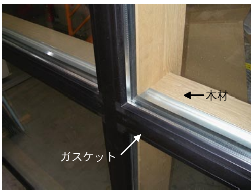
写真10 ガスケット木複合カーテンウォール
