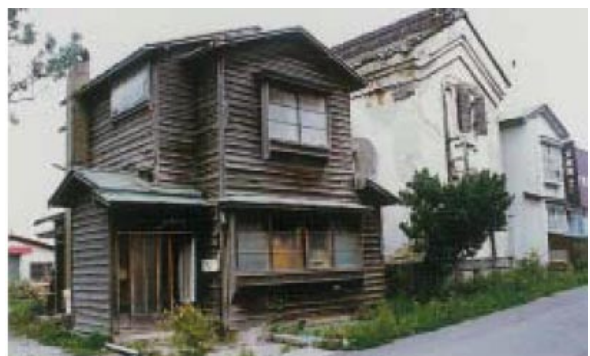
写真2 下見板張りの木造住宅
