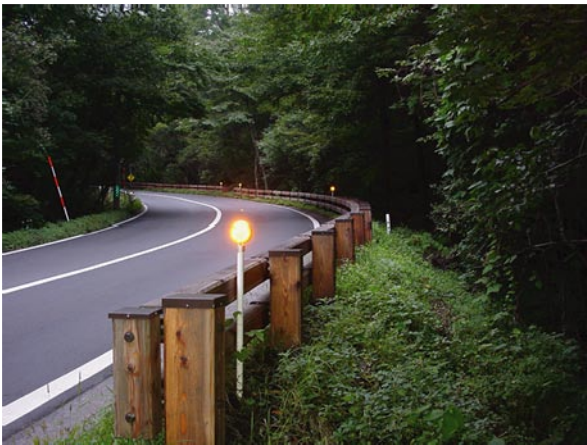
写真 長野県の木製ガードレール（信州2型）
