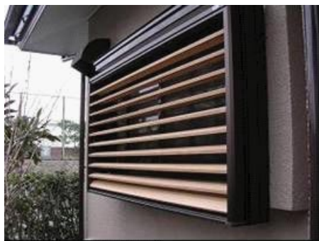
写真3 木製ルーバーの試作（住宅）
