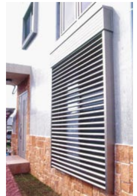
写真 1 電動式ルーバー
