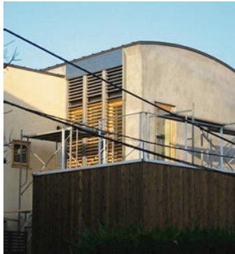
写真 5 高窓への施工事例
