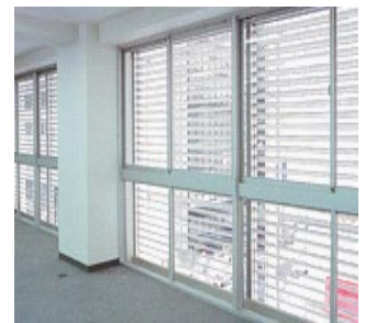
写真 2 大きなガラス壁面のあるオフィスビル (左) とその室内から見たルーバー (右)
