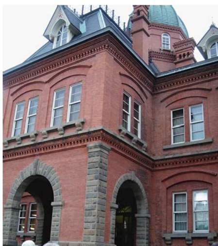
写真1 北海道庁旧本庁舎、通称「赤レンガ」 見たところは、木材の気配もない
