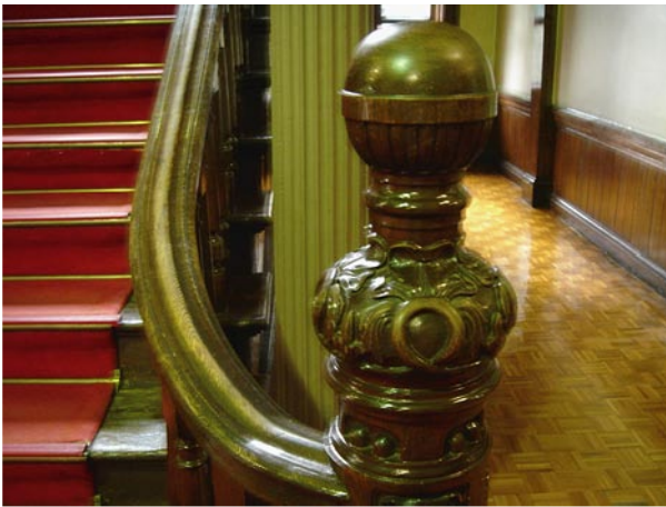
写真3 庁舎の階段手すりに使われている木材は強度性能に優れた北海道産ヤチダモ
