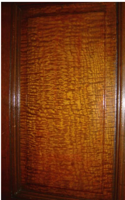
写真4 旧長官室のドアは、ヤチダモの玉杵
